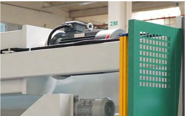
Siemens Main Motor
